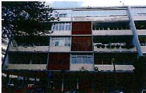
Fig. 33. Vista parcial dos blocos de habitação da Rua Pedro Ivo. É possível observar algumas das alterações efetuadas na fachada: eliminação de grelhas de cerâmica, fecho de varandas com a colocação de caixilharia de alumínio. PM, 20 de novembro de 2019.
