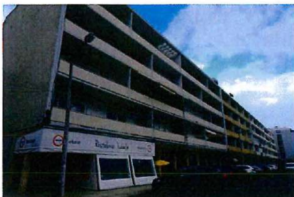
Fig. 16. Vista parcial dos Edifícios da Rua Antero de Figueiredo. PM, 20 de novembro de 2019.
