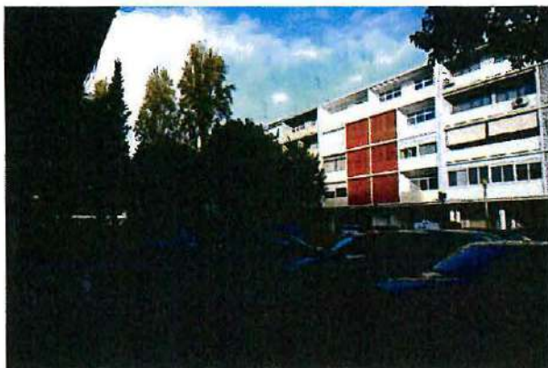
Fig. 49. Vista para o logradouro da Rua Pedro Ivo (junto à Av. Frei Miguel Contreiras). PM, 20 de novembro de 2019.
