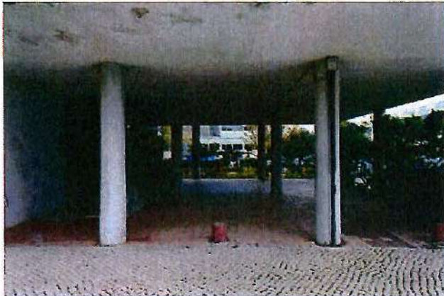
Fig. 27. Bloco de habitação da Rua Bulhão Pato, pormenor do espaço de passagem entre pilotis, criando as transparências de vãos ao nível do piso térreo, que permitem o acesso ao interior do logradouro. PM, 20 de novembro de 2019.
