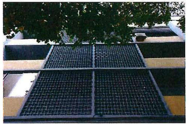
Fig. 30. Bloco de habitação da Rua Bulhão Pato (lado poente), pormenor das grelhagens de cerâmica da fachada. PM, 20 de novembro de 2019.
