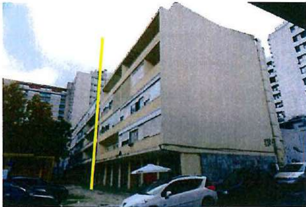
Fig. 12. Conjunto de edifícios na Rua Bulhão Pato, vista a partir da Rua José Pinheiro de Melo. PM, 20 de novembro de 2019.
