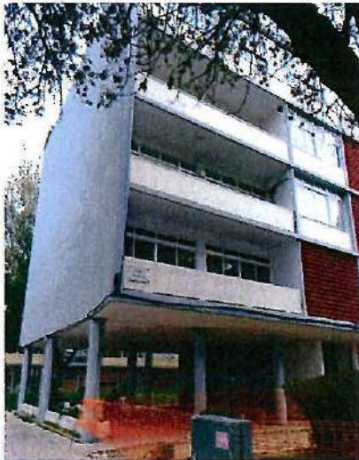
Fig. 31. Vista parcial dos blocos de habitação da Rua Pedro Ivo. PM, 20 de novembro de 2019.
