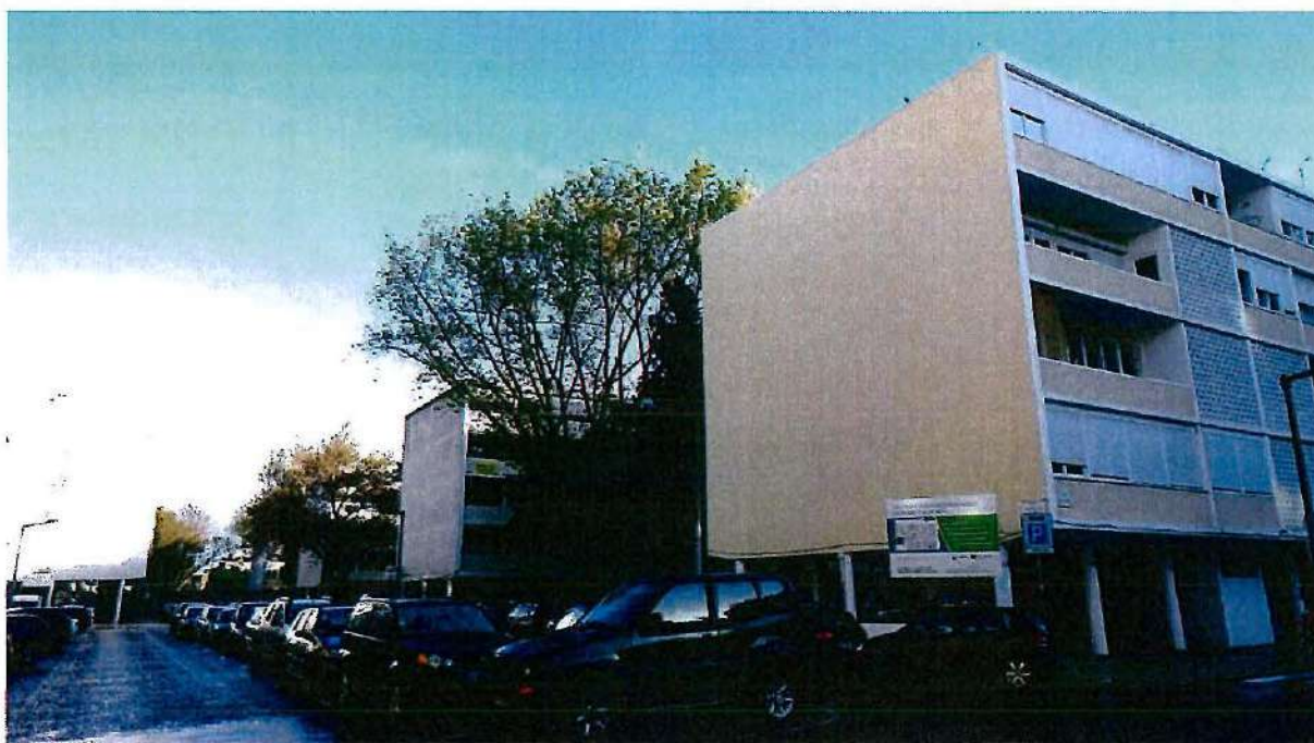
Fig. 24. Blocos de habitação do Bairro das Estacas (grupo dos quatro blocos centrais), vista a partir da Rua Antero de Figueiredo. PM, 20 de novembro de 2019.
