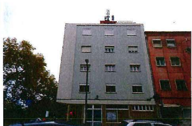
Fig. 23. Vista do edifício de topo da Rua Teixeira de Pascoais, a partir da Rua Dr. Gama Barros. PM, 20 de novembro de 2019.
