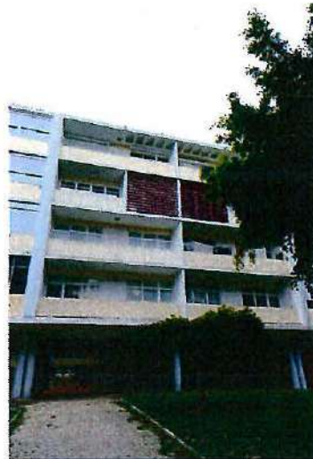
Fig. 32. Vista parcial dos blocos de habitação da Rua Pedro Ivo. PM, 20 de novembro de 2019.
