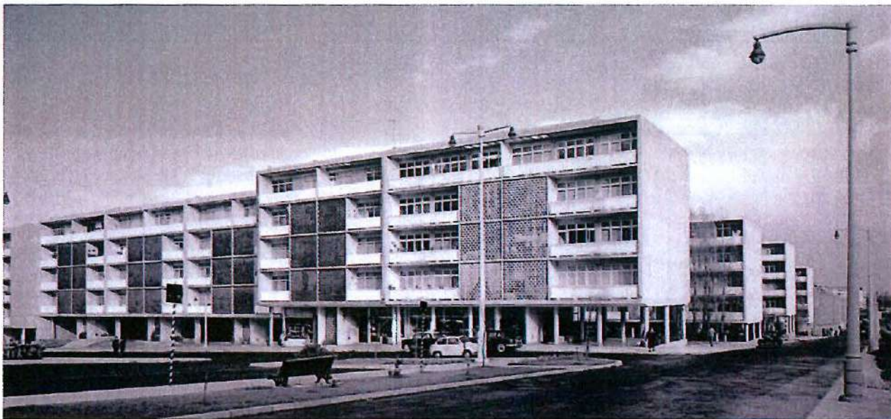
Fig.54. Blocos de habitação do Bairro das Estacas. Foto Armando Serôdio, 1959.
