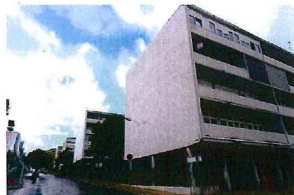
Fig. 42. Vista para os blocos do Bairro das Estacas, a partir do cruzamento da Avenida Frei Miguel Contreiras com a Rua Teixeira de Pascoais (fachadas nascente). PM, 20 de novembro de 2019.
