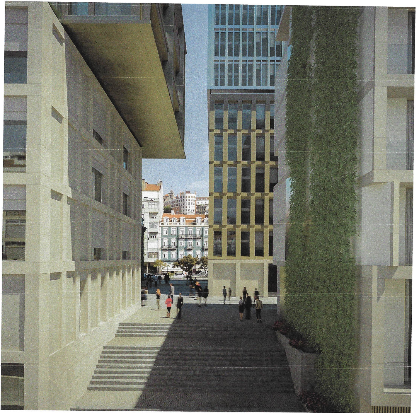
Atravessamento entre a Rua António Pedro e a Av. Almirante Reis
