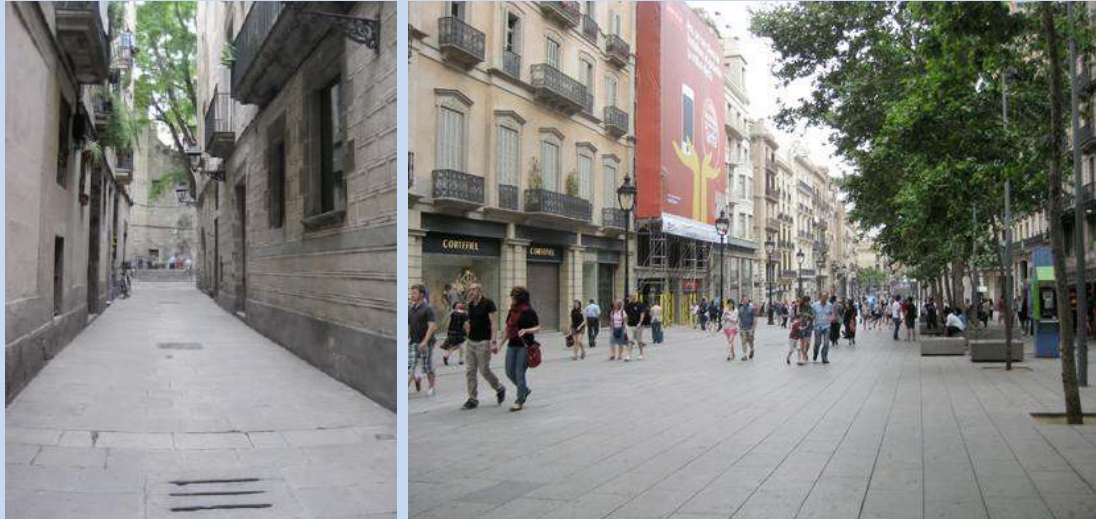
Rua no Bairro "Gótico" pavimentada com lajes de arenito / Avenida Portal del Ángel com lajes de granito.
