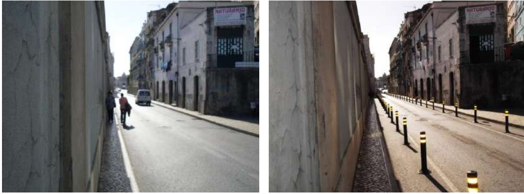
Fotos 12.5.3.b e 12.5.3.c – Rua do Norte, antes (esq.) e depois (dir.) da intervenção da CML (2012)
