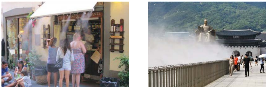
Figura 7 – Exemplos de estratégias de arrefecimento evaporativo por sprays de água: integrados em toldos acima da altura de uma pessoa [1] e em estruturas no solo à abaixo da altura de uma pessoa [23].
