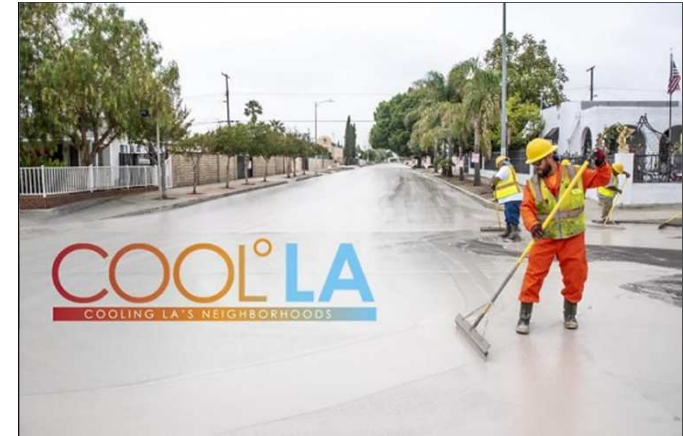
Medida 3 – Pintura pavimento
