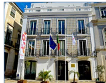
Edifício do Lg. do Intendente 40-42 – Junta de Freguesia de Arroios
